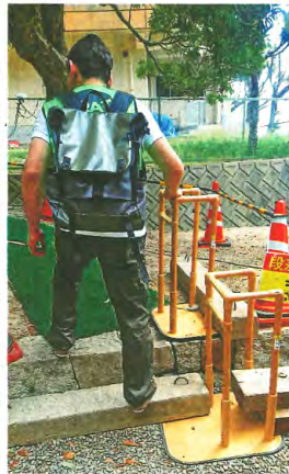
西日本豪雨で被害を受けた倉敷市真備町地区で、段差のある場所に手すりを設置
